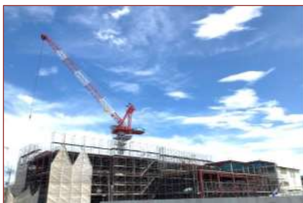
2018.9「工事中のタワークレーン」
