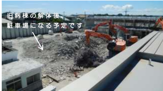
この辺りが旧棟の玄関でした
