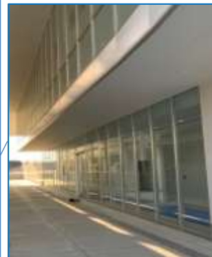
アプローチ デッキ
